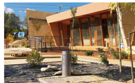
Tobera de aireación asociada al sistema de recogida de aguas pluviales, dispuesto en el bosque climático.
