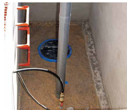
Instalaciones realizadas en el subsuelo del jardín que circunda al edificio, que consta fundamentalmente del aljíbar, el sistema de bombeo del agua y las tuberías asociadas.
