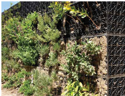
Preparación de un jardín mural exterior mediante cajas estructurales de polietileno que permite contener la tierra o el sustrato.
