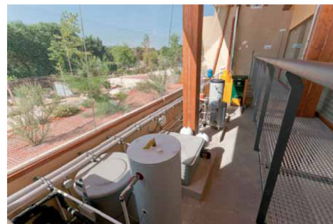
instalaciones de fontanería y saneamiento (cuartos húmedos). Es eficaz por tanto, que cuente también con los cuartos destinados a acoger las instalaciones de biomasa y acceso a el solado sanitario y en su frente, se disponen tras una gran cristalería, una batería de colectores de tubo de vacío destinada a dotar de agua caliente sanitaria y los depósitos, calderas, bombas y controles que deben regular el confort térmico del edificio. La imagen sugiere un escaparate con las energías renovables que le sirven.
