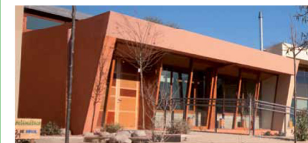
Aspecto exterior del módulo 2.
