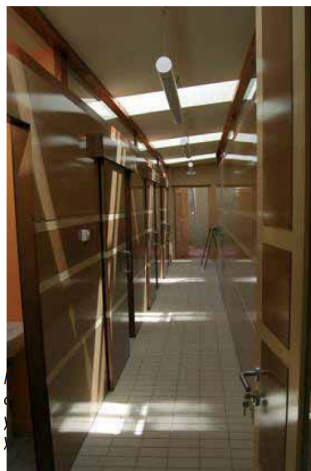
Módulo tercero, cuarto de instala- ciones y zona de aseos y vestuarios.
