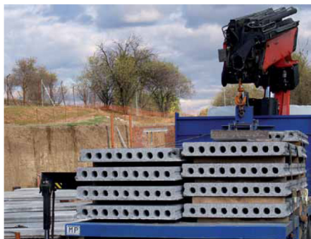
Uso de losas alveolares para los forjados, totalmente modulares y fácilmente desmontables asegura su reutilización sin pérdidas apreciables.
