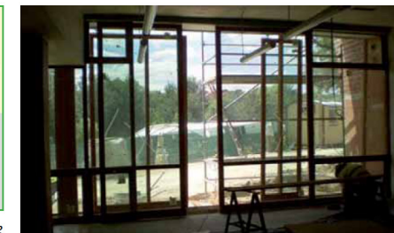
Carpintería en corredera en el módulo aula, permite mantener por la noche del verano una fuerte corriente de aire que recoge el calor almacenado en las masas térmicas y dejarlas preparadas para absorber el calor del ambiente durante el día.
