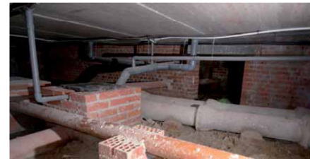
Distribución de las instalaciones de saneamiento y aporte del agua por el forjado sanitario.
