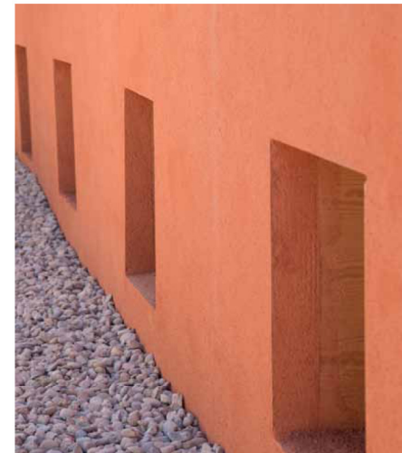
Zona del muro orientación norte, está en una parte importante enterrada, los huecos son de pequeña dimensión para limitar las pérdidas y el grosor del muro es muy significativo, las ventanas retranqueadas al máximo.
