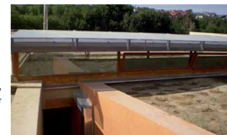
Huecos abiertos para ventilación en cubierta, creando una corriente en dirección ascendente como las chimeneas solares (chimenea termal).
