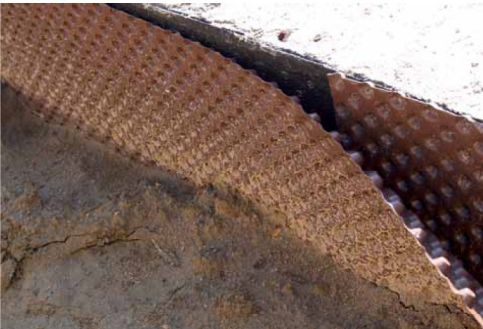
Impermeabilización de la cubierta mediante lámina EPDM.
