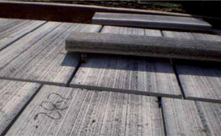
Forjado de hormigón de losa alveolar.
