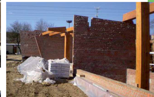
Cerramiento muro ladrillo macizo.
