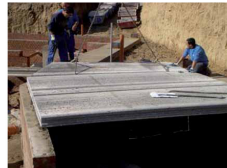
Colocación del forjado de losa alveolar sobre fábrica de ladrillo que configura el forjado sanitario.
