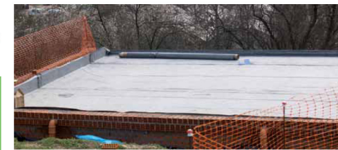
Impermeabilización de la cubierta.
