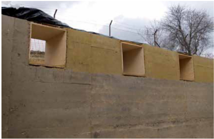
Aspecto del muro lado norte del módulo.
