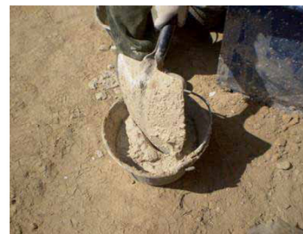
Acopio y preparación del mortero de barro.
