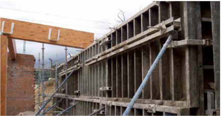
Preparación del muro tapia, a base de un encofrado para contener la tierra compactada.
