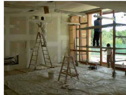
Cobertura del cerramiento base de trasdosado de cartón yeso.
