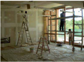
Colocando trasdosa-do de cartón-yeso.
