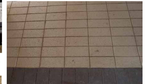
Pavimento de adoquín cerámico.
