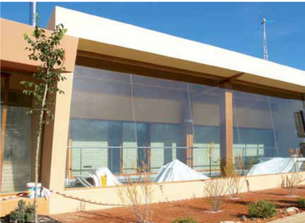
Acristalamientos de amplias dimensiones en el módulo 3. (instalaciones).
