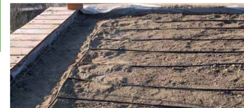
Preparación del riego por goteo en la cubierta.
