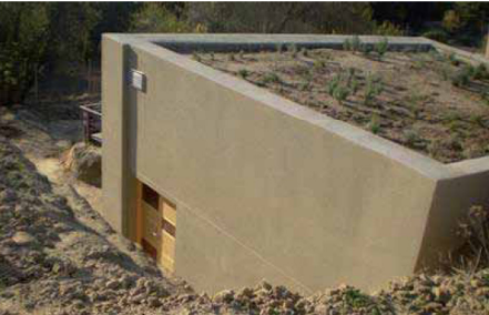
Aspecto exterior del enfoscado (módulo 4).
