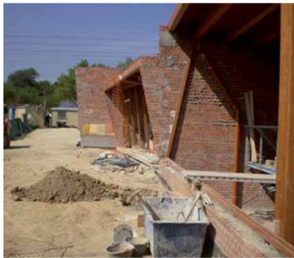
Cerramiento base de ladrillo cerámico.
