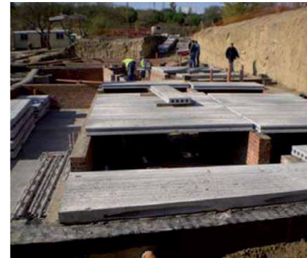
Colocación del forjado de losa alveolar sobre fábrica de ladrillo que configura el forjado sanitario.
