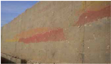
Muro de contención de tierra compactada.
