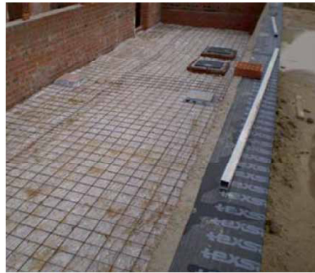
Solera de hormigón armado como cimentación en cuarto de instalaciones.
