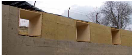
Encofrado perdido para preparar los huecos superiores.
