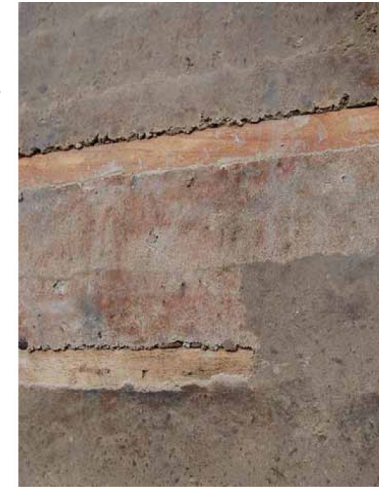
Inclusión de maderas en el propio muro de tapial.
