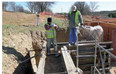
Compactación de la tierra mediante un pistón neumático.
