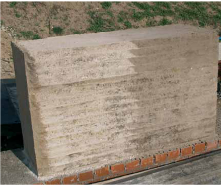
Muro tapia, dispuesto fundamentalmente en los cerramientos laterales del lado norte, en contacto con el terreno.
