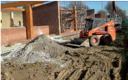
Mezcla de la tierra con la cal y cemento mediante una pala.
