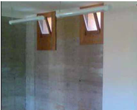
Encofrado perdido para preparar los huecos superiores.
