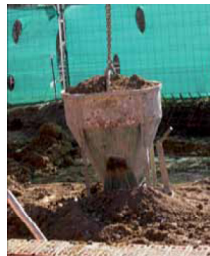
Transporte de la mezcla al encofrado.
