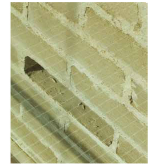
Parte anterior del muro Trombe mostrando la lámina de cristal (invernadero) y el muro de ladrillo.
