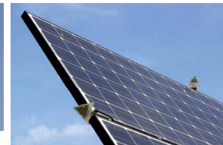
Disposición de los sensores de seguimiento solar en el panel fotovoltaico.
