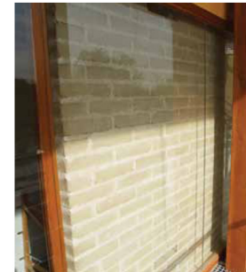
Parte anterior del muro Trombe mostrando la lámina de cristal (invernadero) y el muro de ladrillo.
