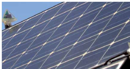
Estructura de paneles solares de 5 KW, con seguidor instalado en la zona izquierda del edificio del CREAS, orientada hacia el sur con una posición que se ajusta automáticamente a la máxima radiación solar.
